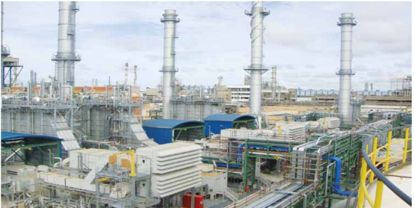
Overview of Gas Turbine Generators and HRSG units
